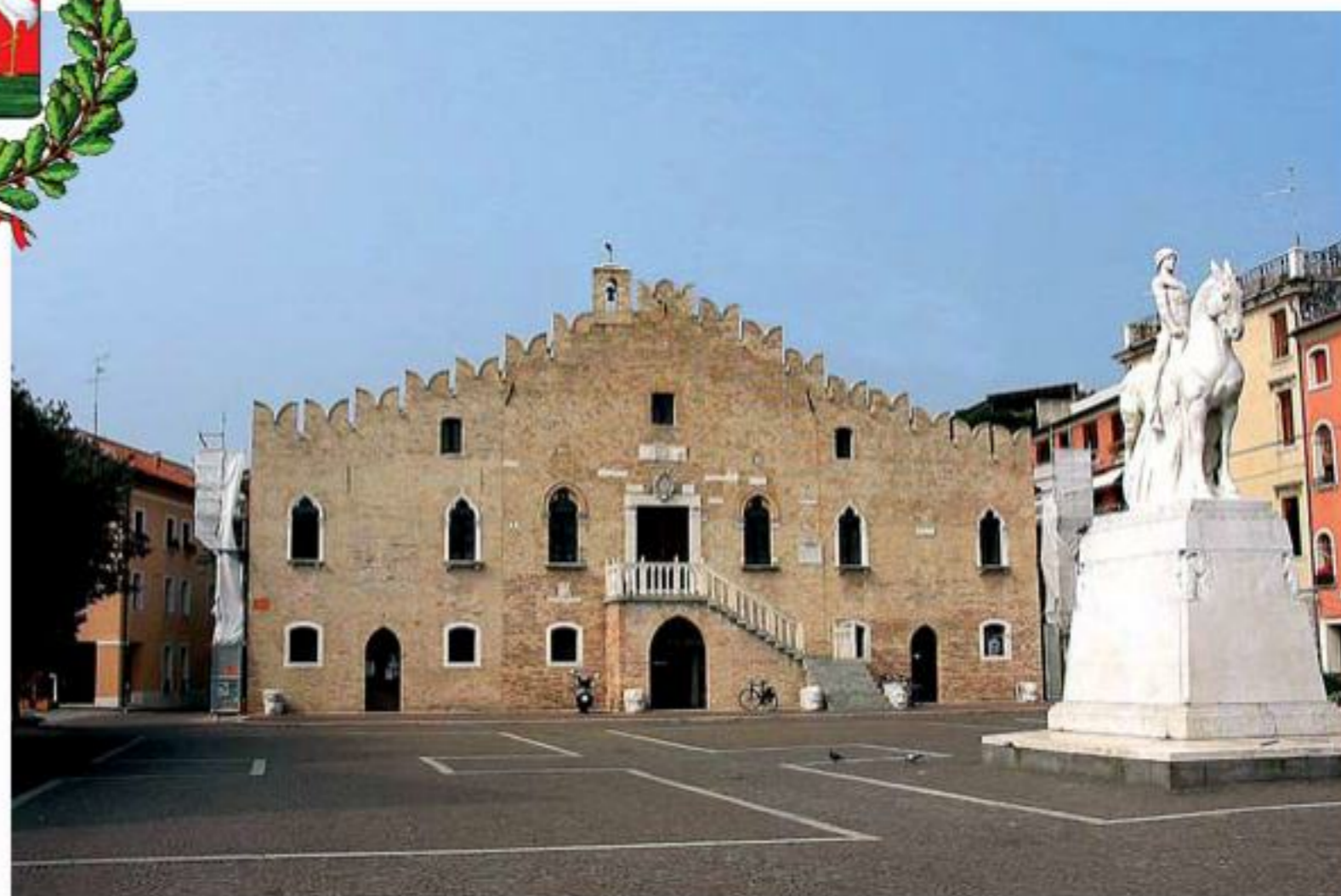
Palazzo della Loggia, oggi sede del Municipio di Portogruaro; sopra: veduta del centro storico dal fiume Lemene; lo stemma comunale della città
