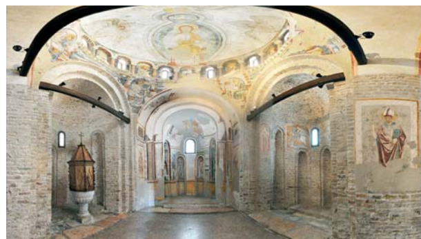
Il Battistero (XI-XII sec.), edificio romanico con affreschi dell'epoca, a pianta greca, è formata da un quadrato centrale con tre absidi su tre lati; sotto: la Cattedrale di Santo Stefano; una veduta esterna e la pavimentazione musiva del V secolo nella Basilica Apostolorum maior
