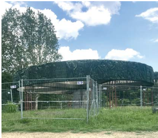
Nelle foto: transenne circondano il Monumento all'Autiere di Torino; in alto: il monumento prima del degrado
