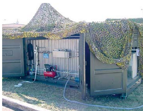
Potabilizzatore OMP/POT1 in dotazione ai contingenti in Afghanistan e Libano ed impiegati anche per l'operazione "White Crane" ad Haiti
