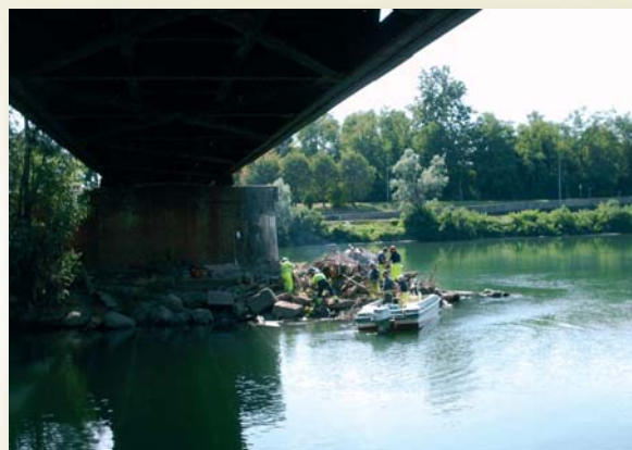
L'intervento dei Volontari del Gruppo di San Bassano per rimuovere tronchi e rami sotto un ponte ferroviario
