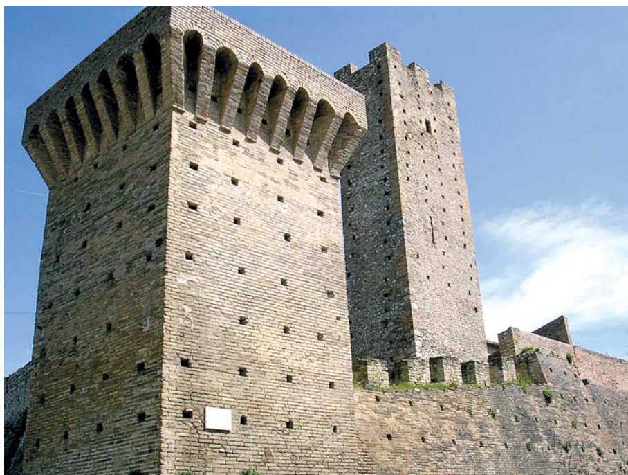
Le Torri Montanare di Lanciano
