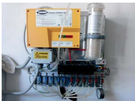
*Sopra: manutenzione di un deposito carburanti di nuova generazione; a sin.: dispositivo di rilevamento perdite a depressione; in alto: sezione di cisterna monoparete trasformata in doppia parete con l'applicazione di resine epossidiche; sotto: modello di deposito carburanti "normalizzato"*
